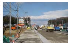
(玉貫地区道路舗装工事)
