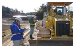
(油井川野辺川原地区工事)
