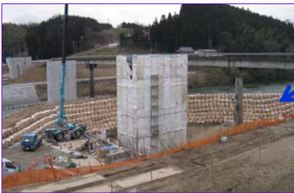
(工事現場の様子)
