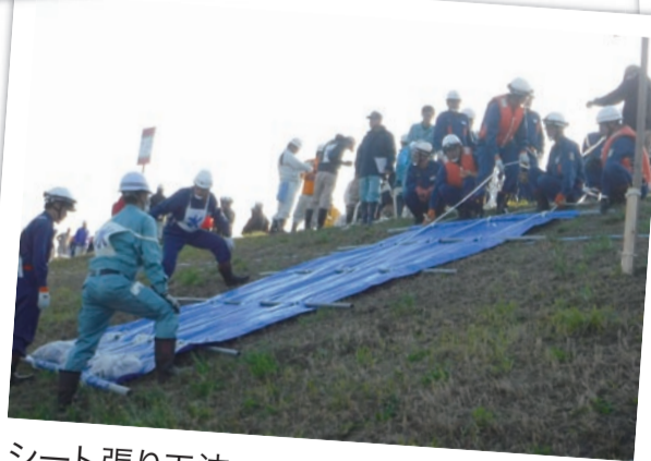
シート張り工法
