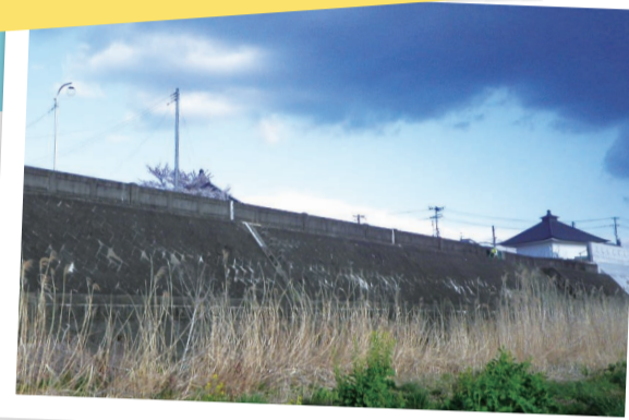
Cゾーン 工事前(上)と工事後(下)
