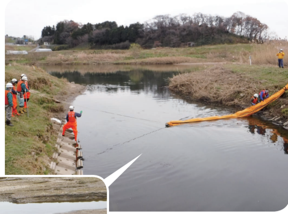
◀ オイルフェンスを設置することで、河川に流出した油類の拡散を防ぐことができます
