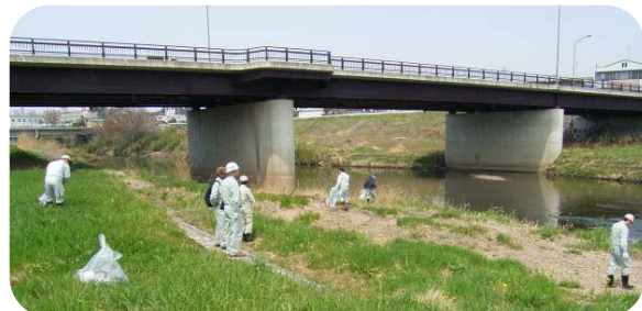
須賀川市との合同点検（ゴミ拾い）
