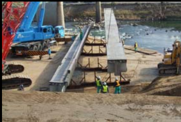
橋桁をクレーンで吊り下げ、河川敷で小割にして撤去しました。
