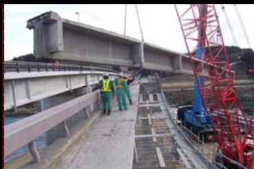
橋桁をクレーンで吊り下げ、河川敷で小割にして撤去しました。
