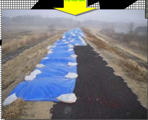
深い亀裂の雲水峰橋下流右岸堤防
