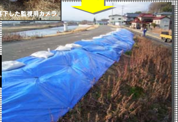
一部が沈下した阿久津橋右岸下流堤防
