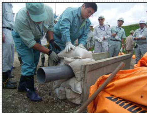
側溝での流出防止策
