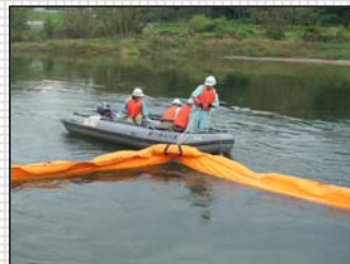
オイルフェンス設置②
