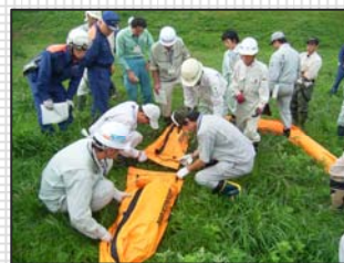
オイルフェンス設置①
