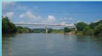
船上から見た阿武隈橋
