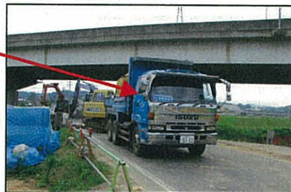
《油井川橋下部工工事現場》
