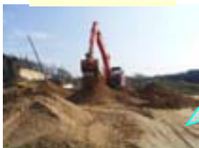
油井川築堤工事
