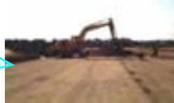
阿武隈川左岸 油井地区築堤工事
