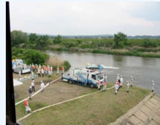
排水ホースのセッティング！
