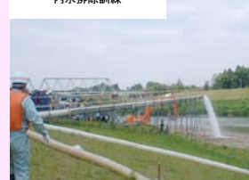
内水排除訓練
