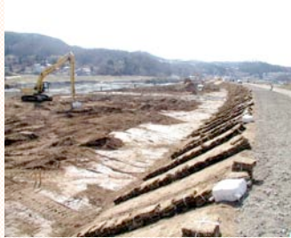
<工事現場状況>
