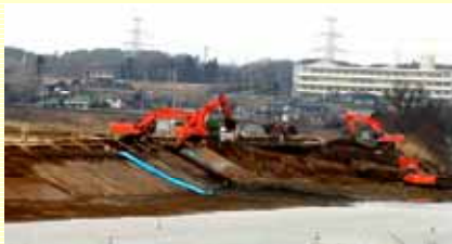
バックホウによる土砂掘削
