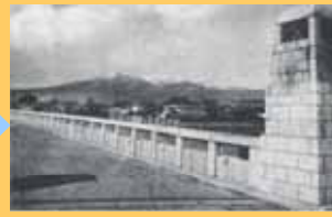
昭和11年に架け替えられた安達橋
