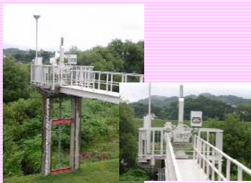
八代さんが操作を担当している水穴樋管です。
