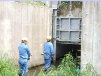
＜ゲートの点検＞
