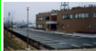
郡山河川防災ステーション外構工事 施工: 公益土木(株)
