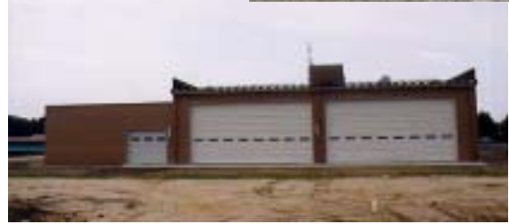
郡山河川防災ステーション格納庫新築工事 施工：陰山建設株式会社
