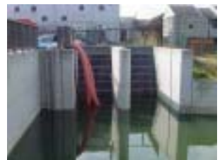
排水ピットの状況
