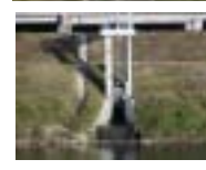
日向第二樋管 郡山市西田町鬼生田石畑地内 高さ1.75m×幅1.75m×1連 トンネルが1カ所のタイプ
