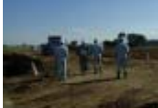
浜尾遊水地築堤工事
