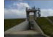
浜尾水門 須賀川市浜尾地内 高さ4.65m×幅3.25m 堤防に橋が架かっている
