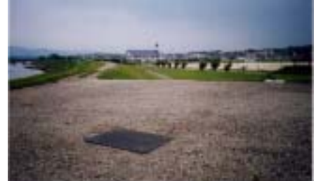
須賀川地区情報通信管路工事 施工:富士工業(株)
