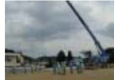
本宮右岸上流地区工事
