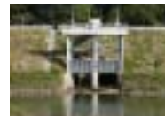
芹沢樋門 郡山市西田町芹沢地区 高さ2.3m×幅3.7m×2連 トンネルが2カ所あるタイプ
