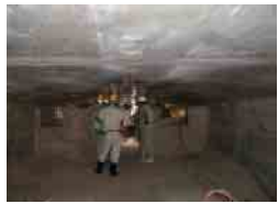
江持橋の上部工内部
