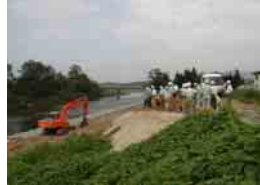
市野関地区工事
