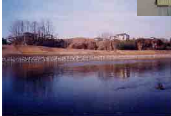
下川原地区工事
