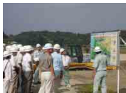
須賀川河川防災 ステーション工事
