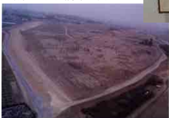
浜尾遊水地工事
