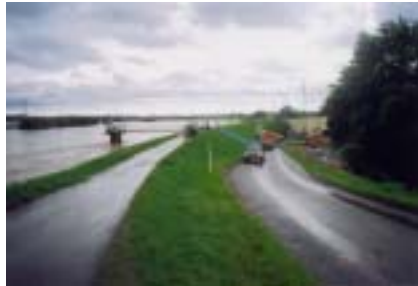
古担樋管と内水排除状況(7/11 7:48) (郡山市)
