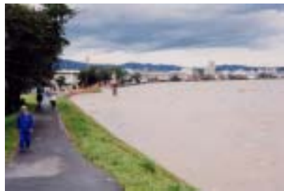
本宮第4樋管付近の出水状況左岸(7/11) 阿武隈川左岸(本宮町)
