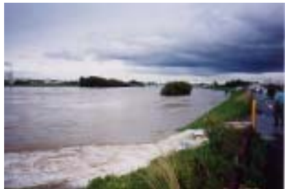
落合堀樋管の内水排除状況(7/11) (郡山市)
