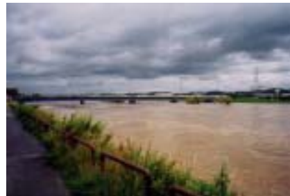
中央大橋の出水状況(7/11 8:35) (郡山市)
