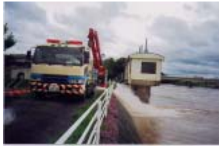
須賀川樋門排水状況(7/11) (須賀川市)
