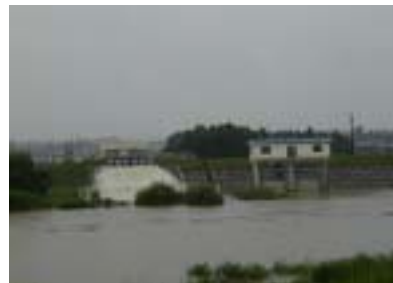
愛宕排水機場排水状況(7/10) (郡山市)
