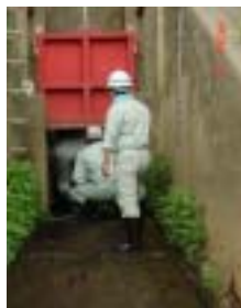
樋管点検状況
