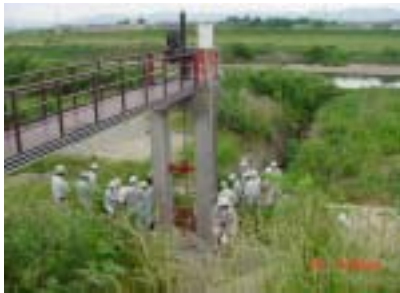
南小泉樋管(郡山市)
