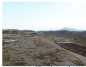
周囲堤の施工状況
