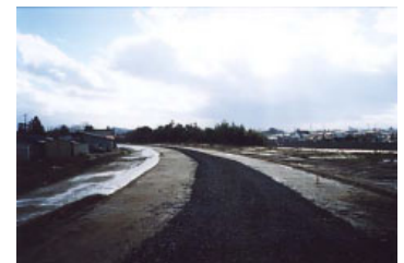
本宮右岸上流地区工事 施工:石橋・川名JV
