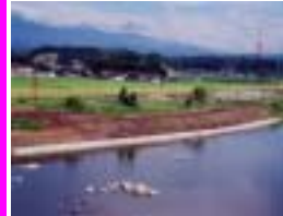
前田第2地区工事 施工:佐藤・国分JV
