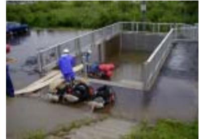
水穴樋管の作業状況
