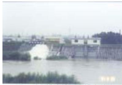
愛宕排水機場の排水状況
