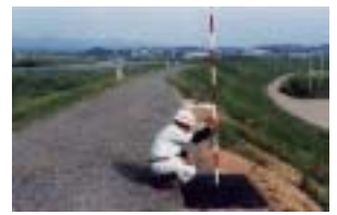
郡山地区情報管路設置工事 施工:(株)星野組
