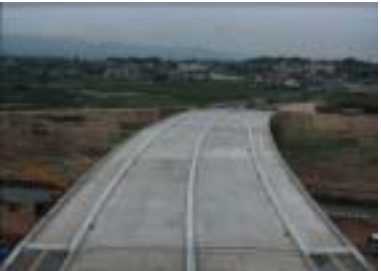
仲の町橋上部工工事 施工：東日本コンクリート(株)
