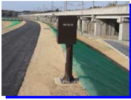
約1キロ毎に設置された「情報コンセント」異常時に真価をを發揮します。
