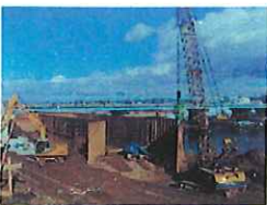
平成13年1月15日引き抜き作業に着手した状況
