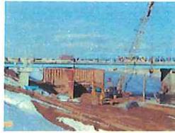
平成13年1月30日現在の矢板引き抜き状況
