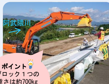
②護岸ブロック施工状況
