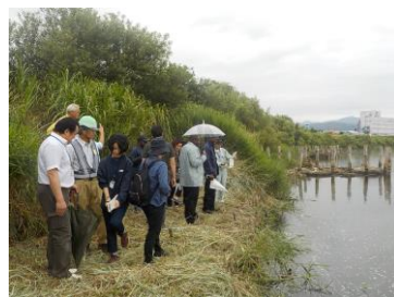
▲鎌田大橋付近「粗朶（そだ）沈床工法（ちんしょうこうほう）」現場
