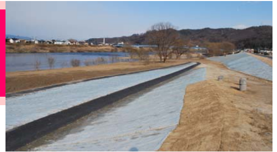
▲2月下旬時点の除染工事の様子。
