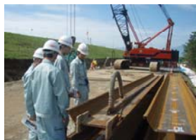
▲矢板工が行われていた堤防強化工事の現場を見学する学生の皆さん。
