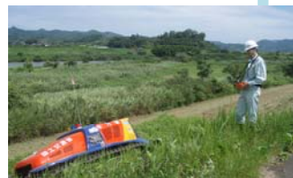
▲遠隔式の除草機械を操作して草刈作業を行いました。
