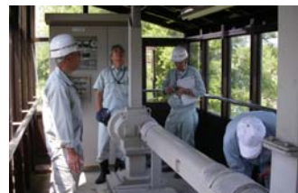
樋門の内部を目視点検しました。
