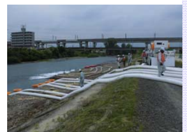
毎分30m 3 を排出する排水ポンプ車を稼働して訓練を行いました。
