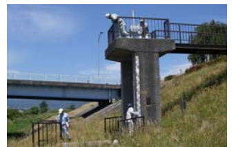
広瀬川の「右城樋管」を点検中。
