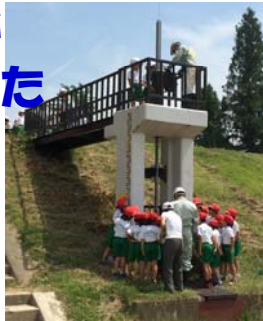
清明小学校と荒川の間位置する福島第9樋管。みんなでゲートが閉まったか確認しています。
