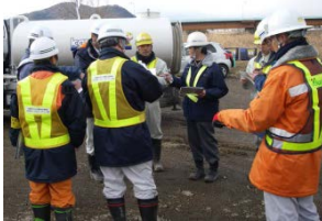
工事事故の防止を図るため、定期的な安全コンサルタント点検を行っています。
