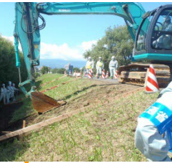
アタッチメント付きバックホーにより堤防斜面の表土を5cm剥ぎ取りました。
