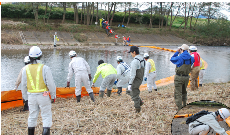
▲油流出事故を想定して松川にオイルフェンスを設置しました
