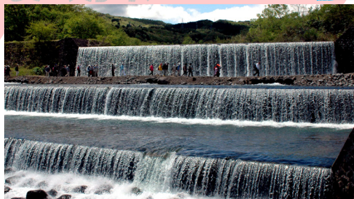
荒川上流の地蔵原堰堤
