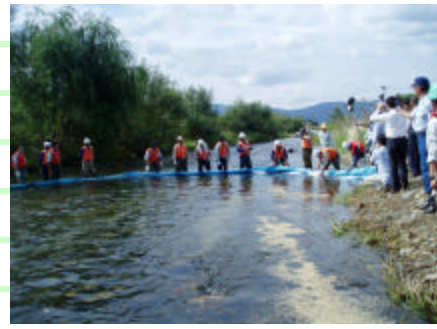
オイルフェンスの設置訓練の様子です。 これで油の流下を防ぎます。
