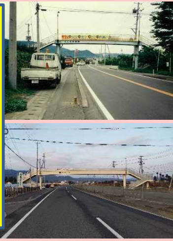
⑥ 桑折町 (久仁内歩道橋付近) (下り)
