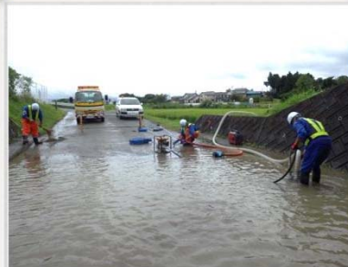
ポンプで排水作業
