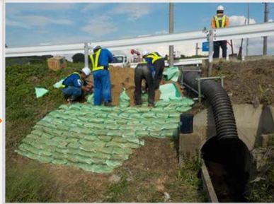
土のうを積んで復旧作業
