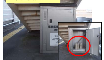
歩道橋階段下
