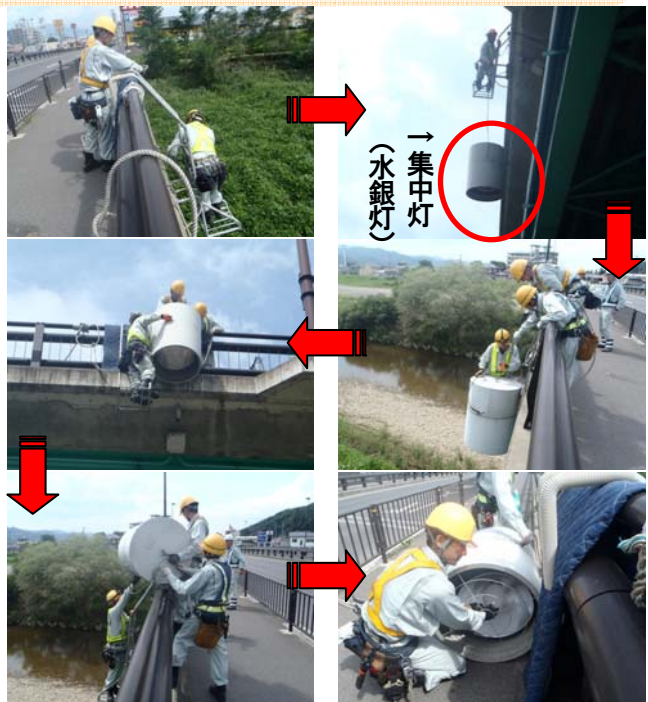
▲集中灯点検作業の様子。作業員が梯子を使って、橋の外から集中灯を持ち上げ、電球に弛みがないか確認します
