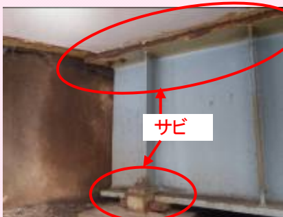
▲傷んだ部分を補修します
