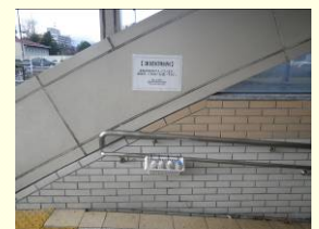
▲地下横断歩道設置状況
