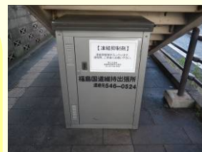
▲歩道橋設置状況
