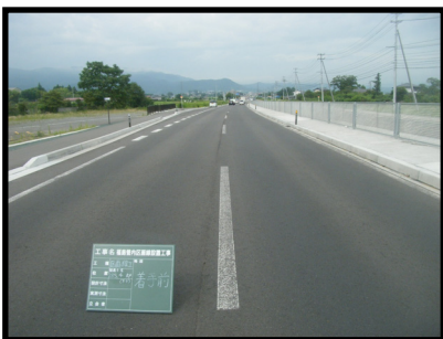
■施工前の状況
