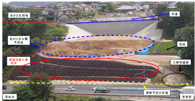
▲復旧工事完了(H24.6.29)
