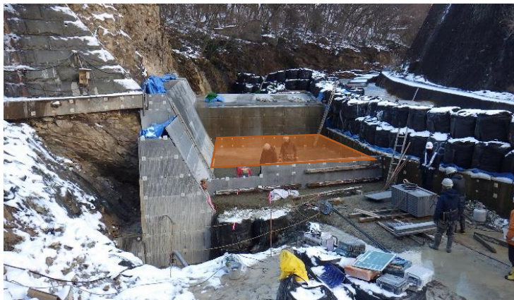
▲取材当日は水叩部の残存型枠組立を行っていました。組立後は水叩部にコンクリートを打設します。
