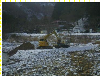
▲重機を使って河川の土をダンプトラックに積み込みます。
