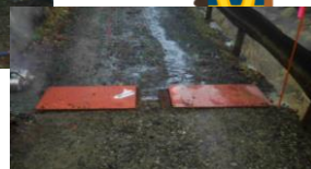
▲温泉水横断箇所を敷鉄板を置いて保護しています
