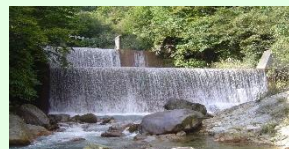
荒川第10砂防堰堤
