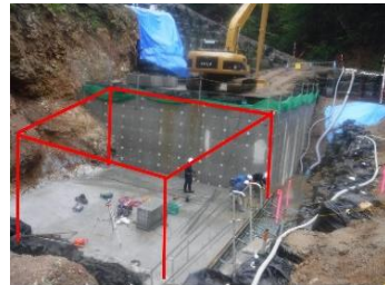
▲赤線のところまで型枠を組み立てながらコンクリートを打設し、土台を造っていきます。
