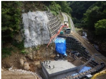
▲型枠の中にコンクリートを打設し、土台を造ります。
