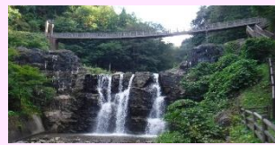
東鴉川第2砂防堰堤 R4.10月撮影
