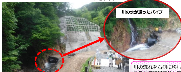
▲作業しやすいよう、川の水をパイプに通し右側に寄せて作業しています。土台の左半分が完成したら、今度はパイプを左側に切り回します。
