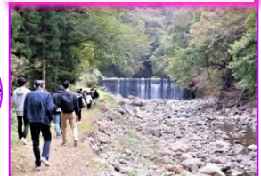
荒川第1砂防堰堤
