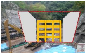
【透過型砂防堰堤】建設イメージ
