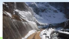
荒川法面 R4.2/14撮影
