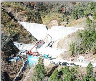
▲下高湯沢第1砂防堰堤上空写真
