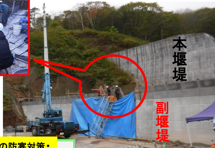
▲副えん堤袖部の高さを13.8mまで上げる残存型枠立て込み作業中
