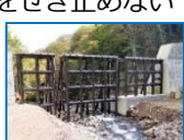
塩の川第7砂防堰堤
