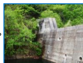
天戸川第1砂防堰堤
