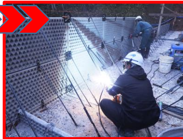
▲副えん堤袖部の高さを13.8mまで上げる残存型枠立て込み作業中
