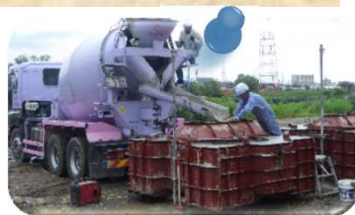
▲仁井田地区右岸にて根固めブロック作成中 R2.7/13現在
