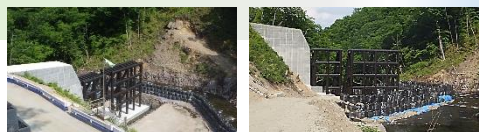
▶塩の川第7堰堤 R2.6.5現在
